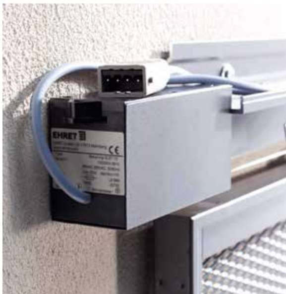
Moteur 230 V | Azionamento 230 V (1)
