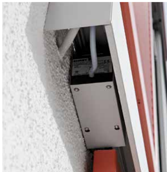
Moteur en situe, installation invisible (1) Azionamento a scomparsa (1)
